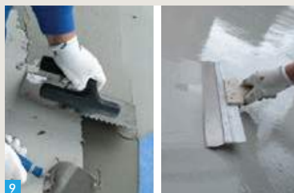
9 Lengvai sudrėkinti visą balkono ar terasos paviršių ir padengti pirmą hidroiziacijos Flex-Dicht sluoksnį.
