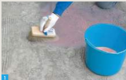
1 Padengti paviršių gruntu Spezialhaftgrund.
