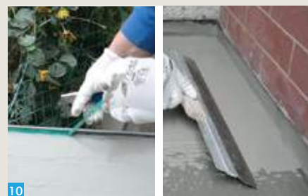
10 Užtepus pirmą hidroiziacijos sluoksnį, nuimti profilių perforaciją apsaugančią juostą. Kai pirmas mišinio sluoksnis išdžiūvęs, padengti kitą sluoksnį.
