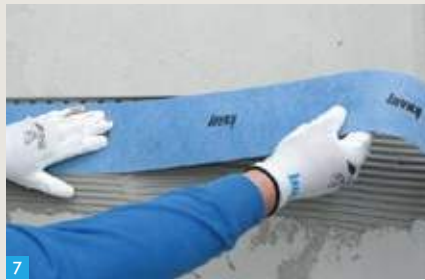
7 Padengti hidroiziacijos Flex-Dicht ant karnizinių profilių. Įplukdyti sandarinimo juostą Flächendichtband į šviežiai padengtą hidroiziacijos sluoksnį.
