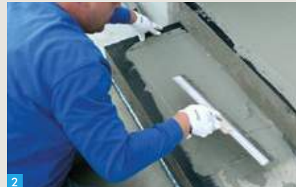
2 Koreguojamuoju mišiniu M1 Repair išlyginti paviršių iki montavimo šablono aukščio.
