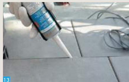
13 Užpildyti siūles hermetiku. Naudoti Sanitär-Silicon.
