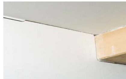
Nelygus trūkis konstrukcijų jungtyse
