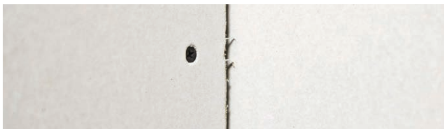
Vidinis kampas su tarpu. Popieriumi dengtą vidinių kampų profilį Las Vegas B2 rekomenduojama naudoti kampams, kai tarpas tarp gipskartonio plokščių yra 2–8 mm pločio.
