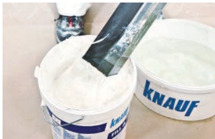
Atskiesti Fill & Finish paruoštą naudoti glaistą vandeniu, kad būtų skystesnės konsistencijos.
