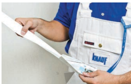
Perlenkti armavimo juostą per centrinį griovelį.
