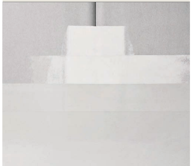
Knauf Uniflott (2 sluoksniai) ir visas paviršius padengiamas storu > 1 mm Knauf Super Finish arba Knauf Pro Spray sluoksniu
