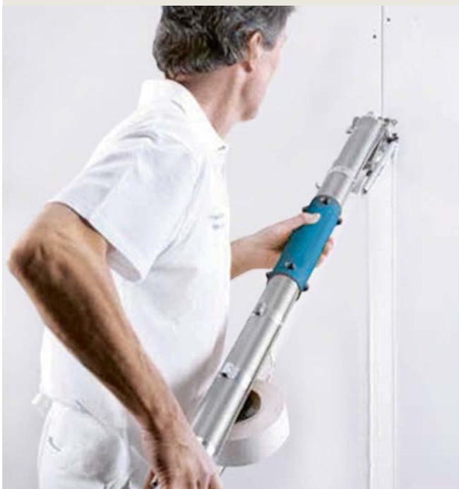
Automatizuotas siūlių armavimo juostų įplukdymas su prietaisu „Bazooka“
