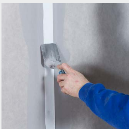
3 žingsnis: glaistykite įplukdykite siūlių armavimo juostą Knauf Kurt
