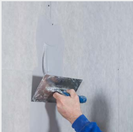
1 žingsnis: užpildykite siūlę glaistu Knauf Drystar-Filler
