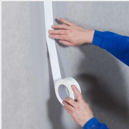
2 žingsnis: įdėkite siūlių armavimo juostą Knauf Kurt
